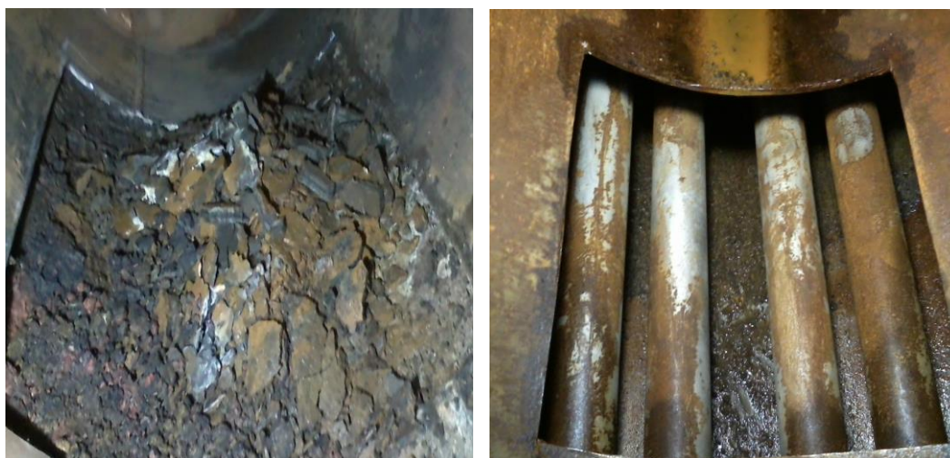
Рисунок 19 – Котел «Dakon» 0,3 МВт до (а) и после (б) очистки
