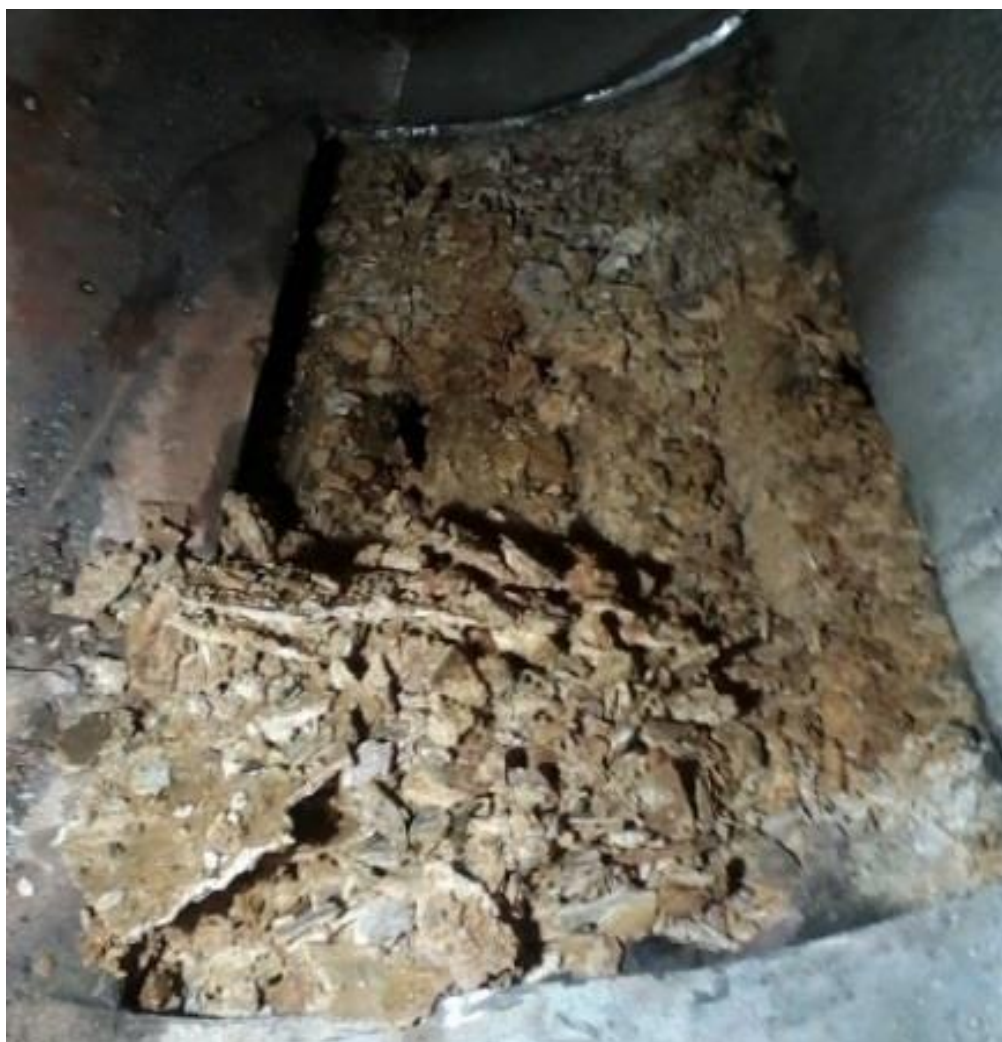
Рисунок 7 – Отложения в аварийном водогрейном котле
