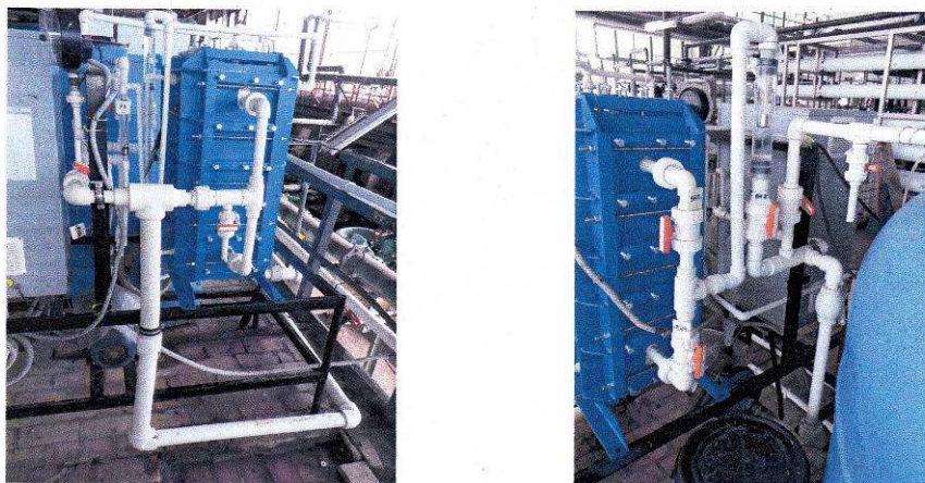
Рис.6 Электродиализатор ЭДС-30-80 в составе гибридного бароэлектромембранного комплекса получения подпиточной воды для котельной ОАО "Каменскволокно"
