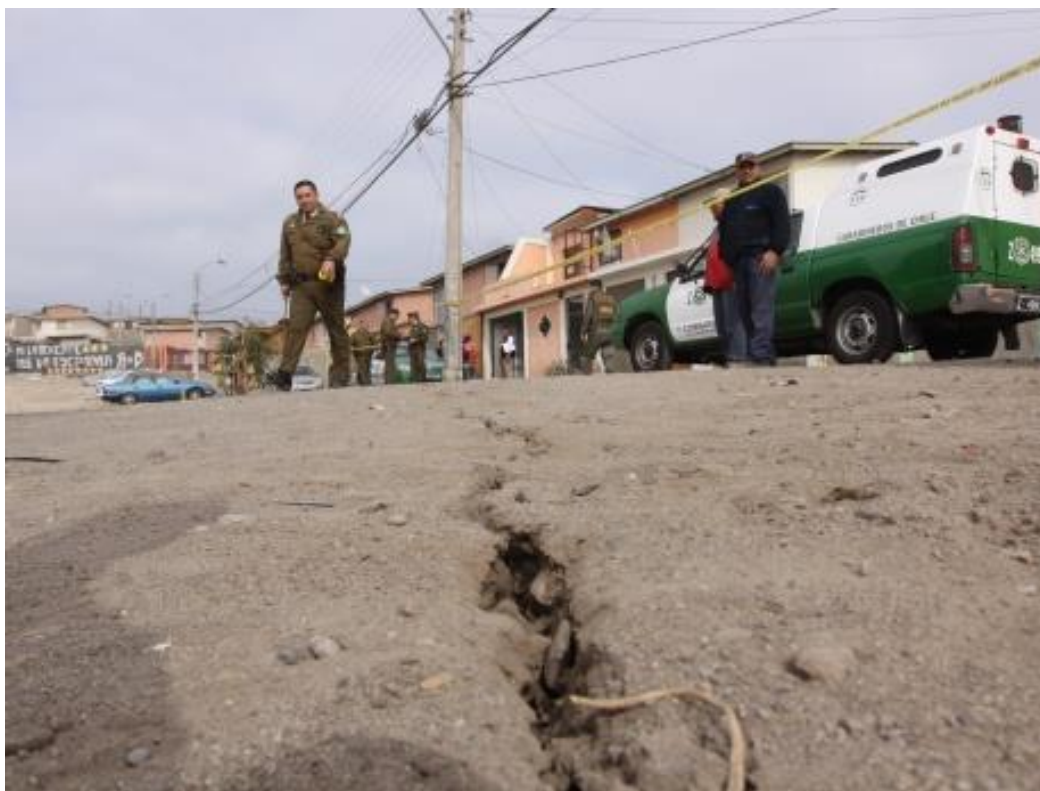
Рисунок 15 – Трещины в предоползневом состоянии. Окончание
