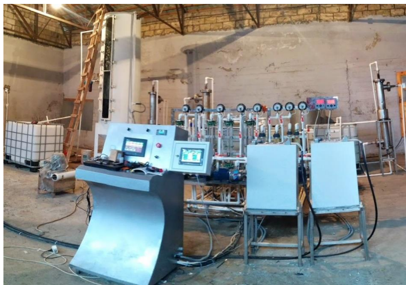
Рисунок 85 – Общий вид электромембранной установки выделения нафтенных кислот из раствора мылонафта натрия
